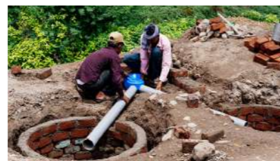
Installing V-Trap toilet
